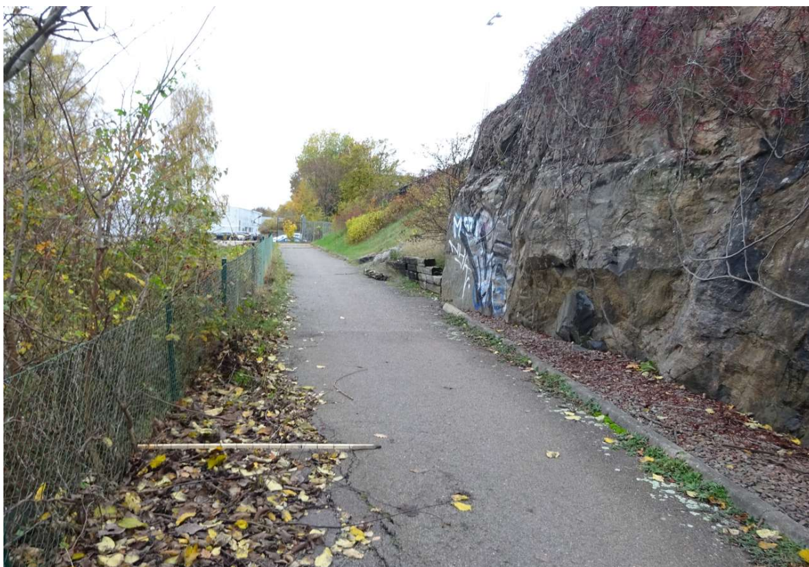
Bild 22 tagen mot väster längs med GC-vägen där man ser området där bergskärningen är som högst.
