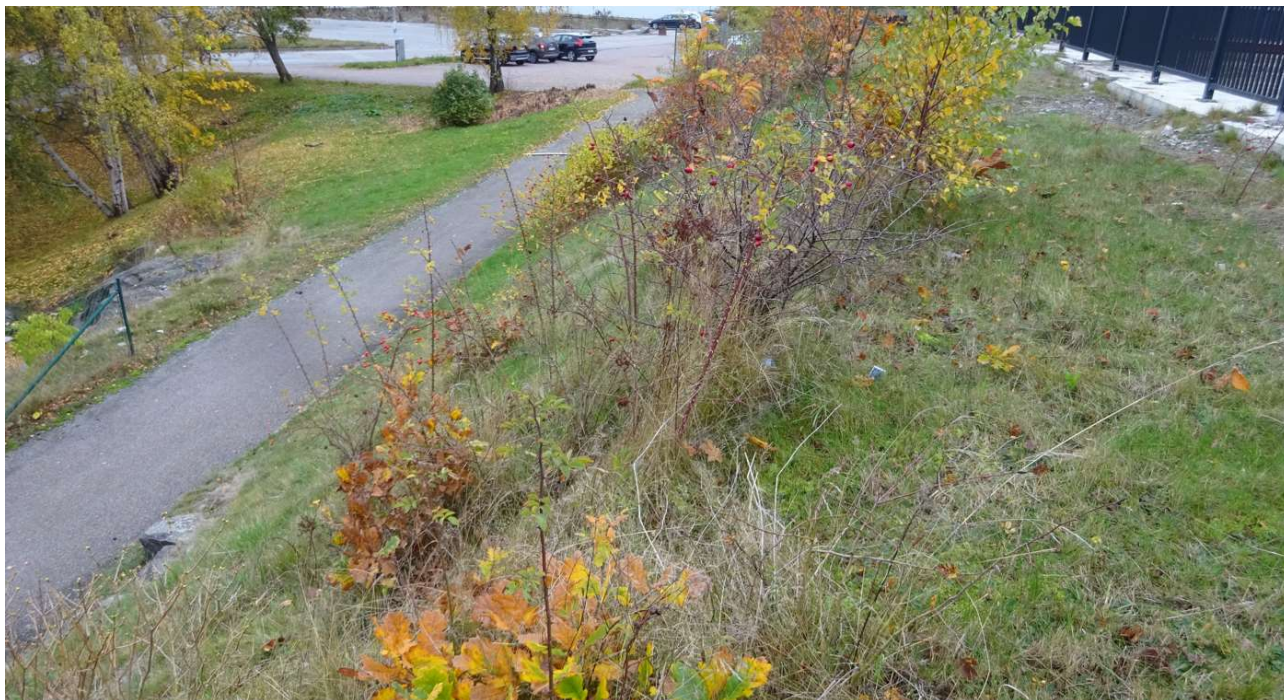
Bild 24 tagen mot väster där bergskärningen sen övergår i en jordsslänt sannolikt med fyllning. Lutningen minskar mot väster i bakgrunden då GC-vägens nivå stiger.
