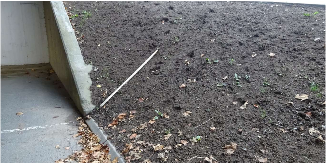
Bild 13 tagen närmare slänten som sannolikt under den organiska jorden utgörs av friktionsjord / bergkross. Ett förslag är att plantera ytan med vegetation som binder jorden.
