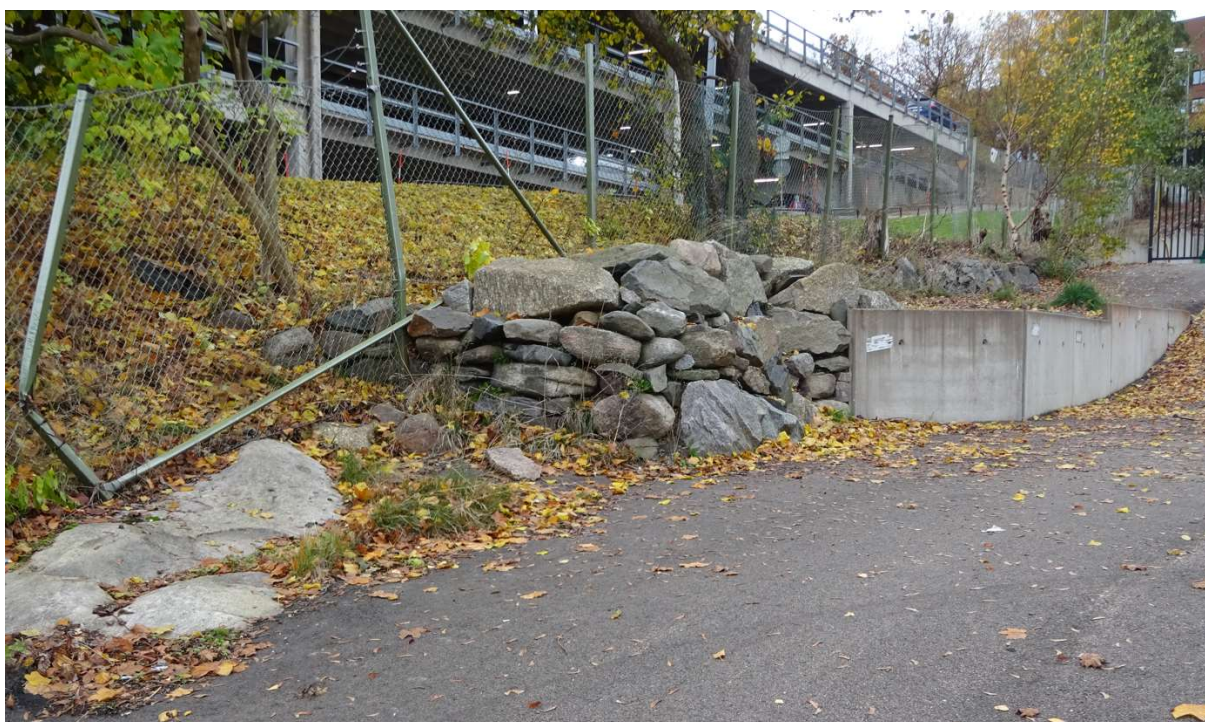
Bild 17 tagen mot nordväst där man också ser det ytliga berget och sedan har en stenmur som övergår i en betongmur anlagts för att ta upp nivåskillnaden från gatan vid P-huset och infartsvägen längst till höger.
