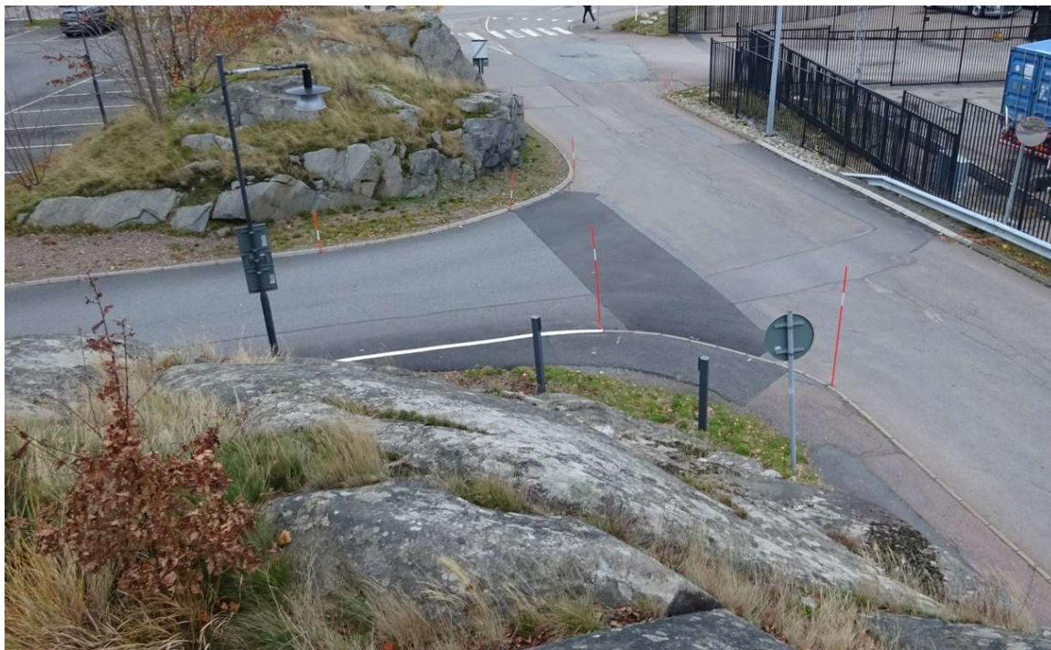
Bild 1 tagen mot öster från berghällen strax väster om infarten till kontorsbyggnaden. Flackt lutande naturligt berg ner mot infarten inom detaljplanområdet. I bakgrunden har mer bergschakt utförts för vägen.
