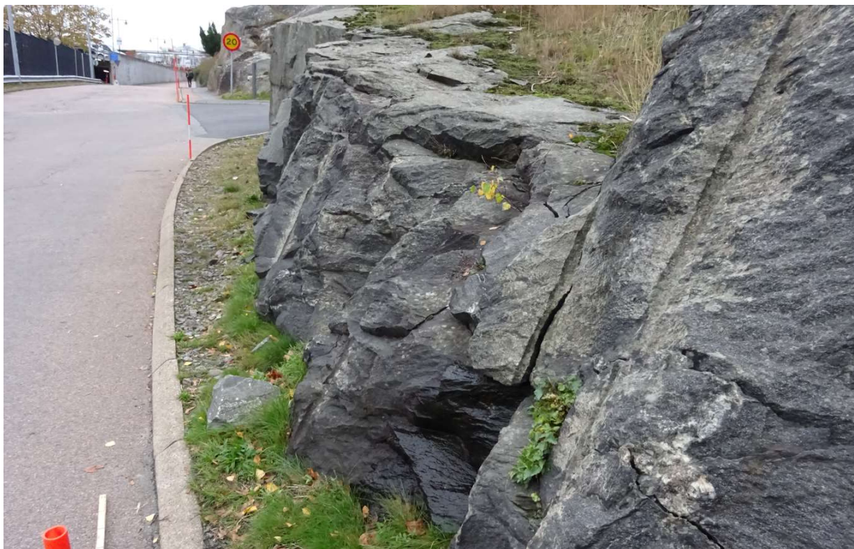
Bild 5 där man ser lösare block strax till högre om mitten. Skärningshöjden är dock låg (<1,5m).
