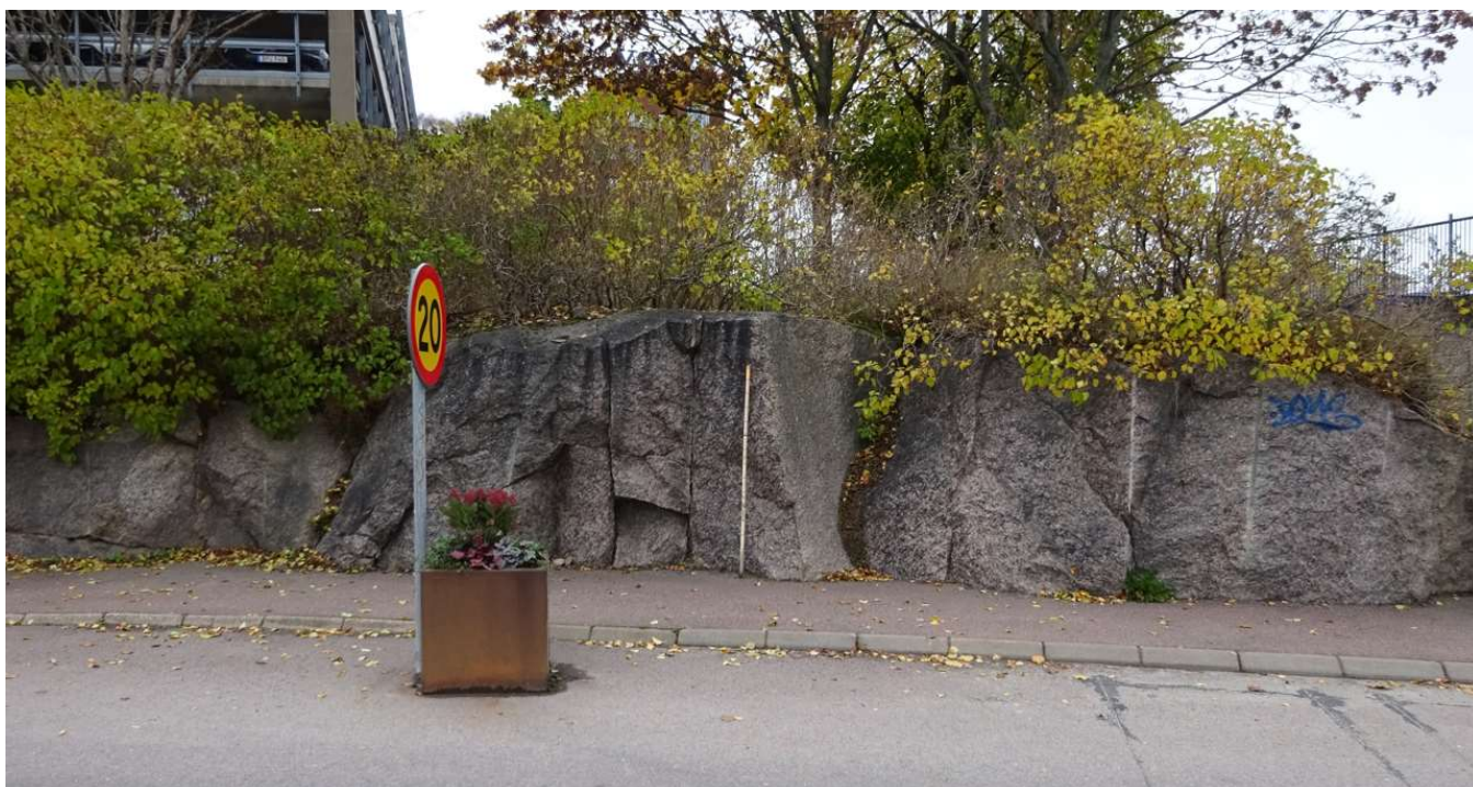
Bild 16 tagen mot norr på den mindre bergskärningen som ligger intill en gångväg upp mot P-huset. Inga stabilitetsproblem föreligger.
