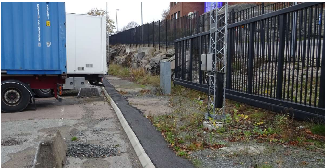
Bild 6 tagen mot väster där man ser att en flack jordslânt klädd med grövre sten övergår till en låg bergskärning.
