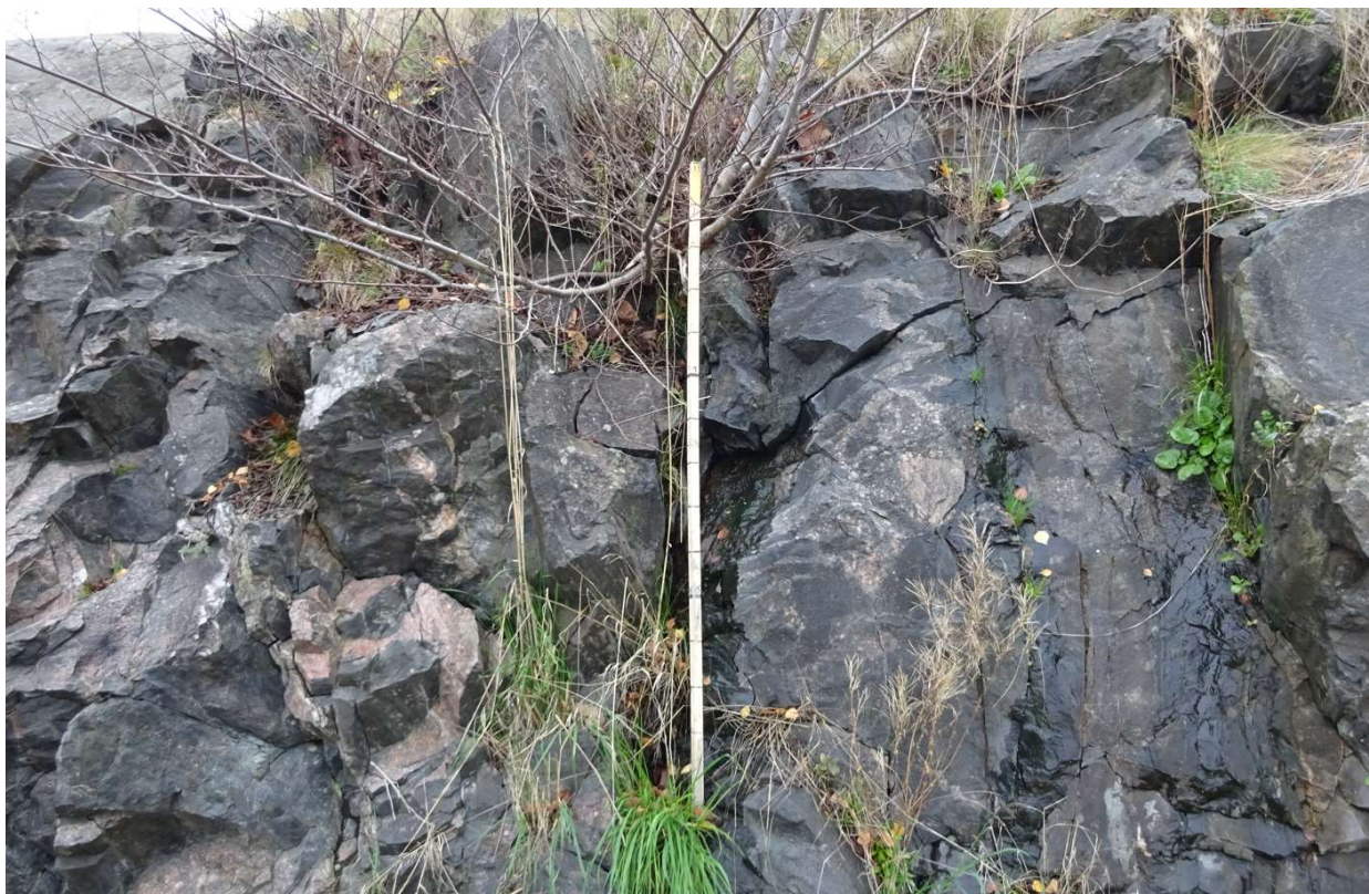
Bild 32 på träd i slänt och lite lösare block intill. Dagvatten verkar ha orsakat mindre sprickor med växtlighet. Skrotning och borttagande av träd bör utföras. Noterbart är att inga åtgärder krävs i nuläget då ny planerad infartsväg innebär att fyllning kommer att påföras.
