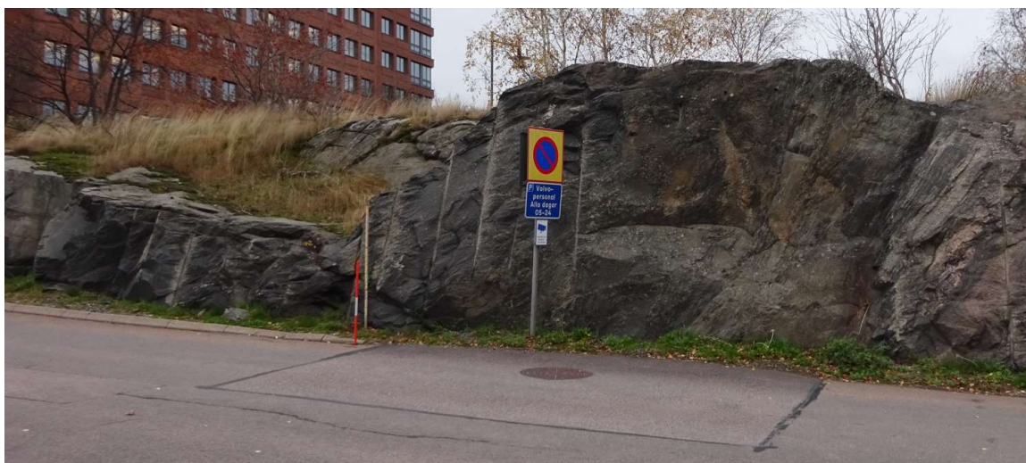
Bild 2 tagen mot norr på den något högre bergskärningen som generellt är massiv .
