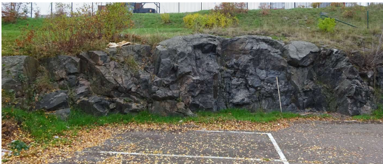
Bild 33 tagen mot norr på nordvästra delen av parkeringen. Inga åtgärder krävas där en del lösare block fanns var lutningen mindre än 45 grader och avståndet till parkeringen större med en gräsyta emellan. Ny planerad infartsväg innebär att inte bergskärningen blir kvar utan fyllning påförs.
