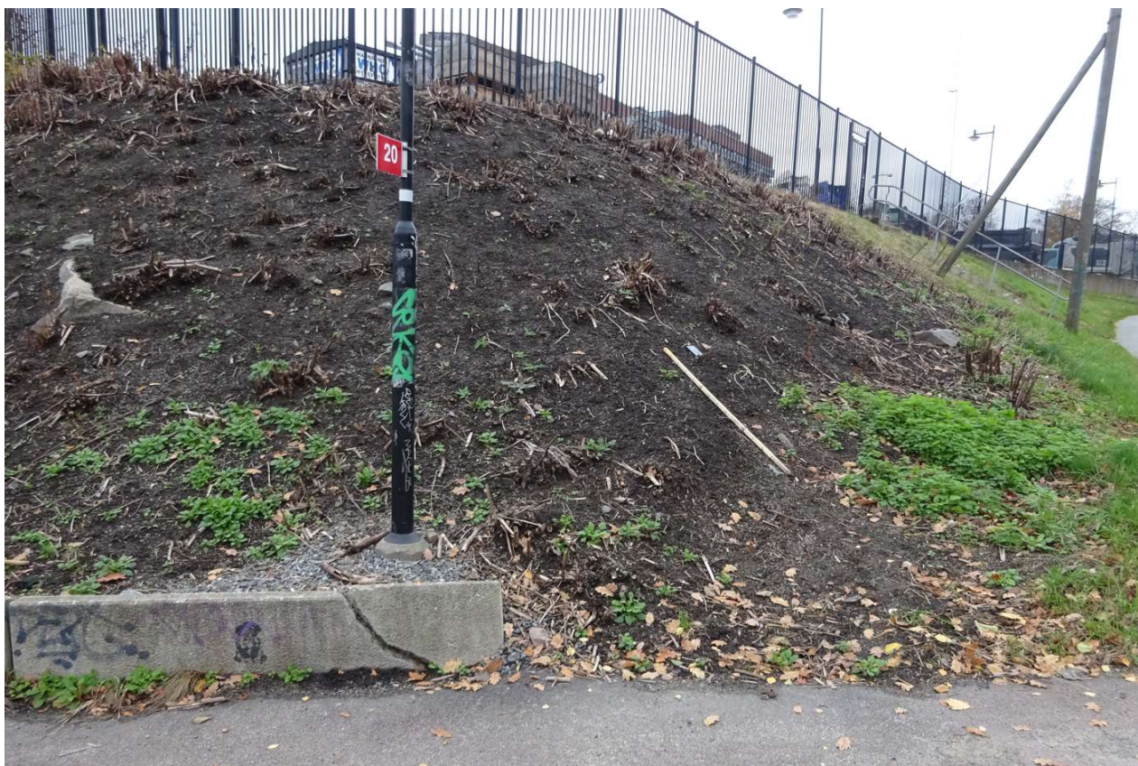
Bild 20 tagen mot norr där man ser att även en lägre betongmur har anlagts längst ner på slänten.
