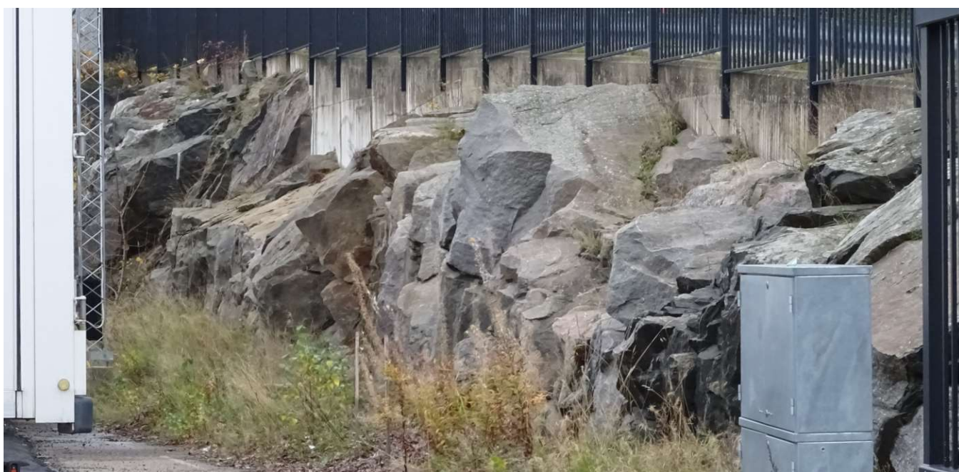
Bild 7 också tagen mot väster där man ser att betongmur med varierande höjd har anlagts närmast vägen.
