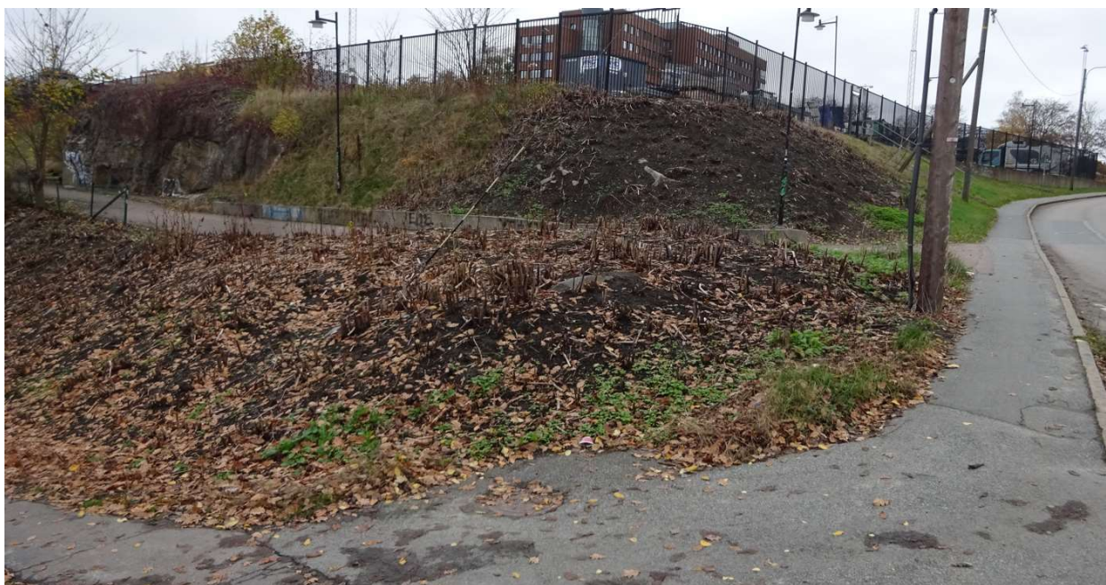
Bild 19 tagen mot norr där man ser att nivåskillnaden är flack söder om GC-vägen men brantare norr om GC-vägen där fyllnadsmassor har påförts på sannolikt ytligt berg.
